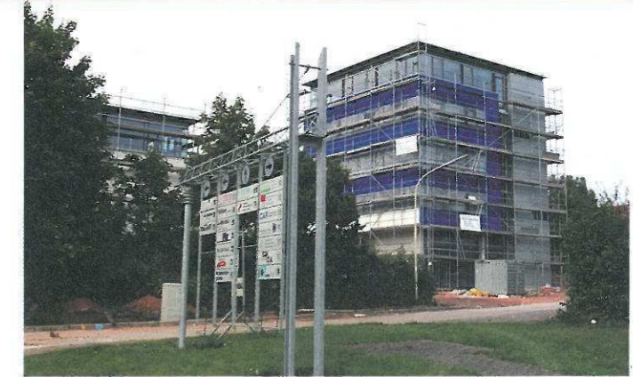
Das Gründer- und Mittelstandszentrum kurz vor seiner Fertigstellung.
