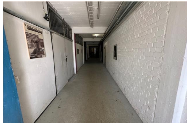
Blick in den Flur der Lagerräume
